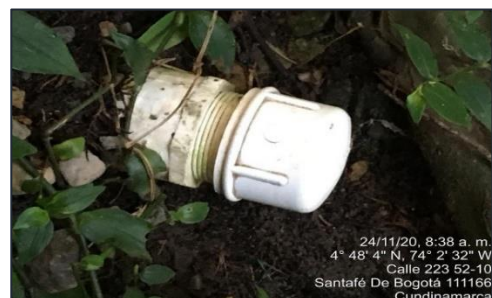
Fotografía 2 Conexión errada no identificada que vierte al Canal Guaymaral.
