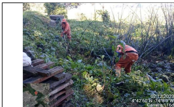
Fotografía 31. Limpieza y retiro de residuos de canal de aguas lluvias
