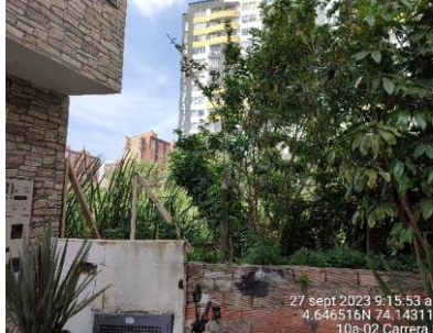
Se observa arreglo de cerramiento provisional en el sector 1.1 de la RDHTE.
