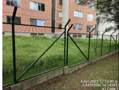
Se observa arreglo de cerramiento en el sector 2 de la RDH Techo.
