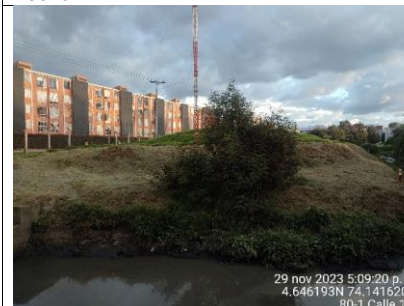
Se observa poda de pasto kikuyo en el talud del jarillon en el sector 1 de la RDH Techo.
