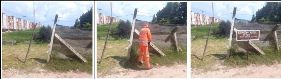
Instalación de equipamientos
