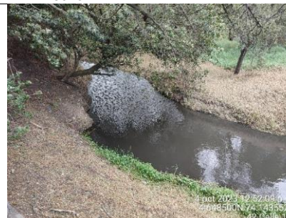
Se observa apertura de espejo de agua en el sector 2 de la RDH Techo.
