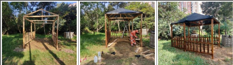
Instalación de avisos
