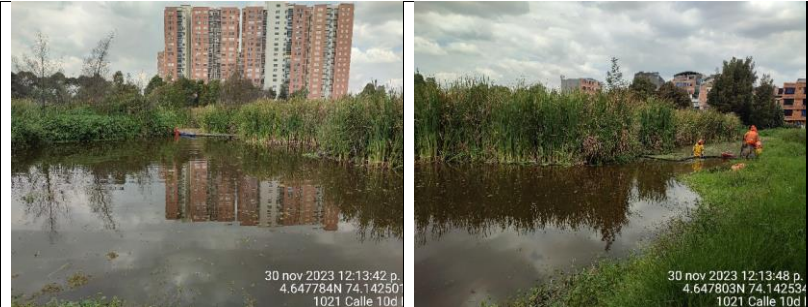
Se observa apertura de espejo de agua en el sector 2 de la RDHTE.
