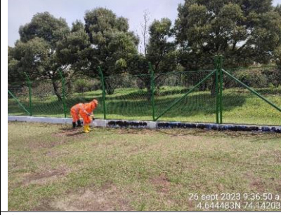
Se observa arreglo de cerramiento definitivo en el sector 1 de la RDHTE.
