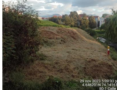
Se observa poda de pasto kikuyo en el talud del jarillon en el sector 1 de la RDH Techo.
