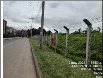
Se observa instalación de malla tipo gallinero en el sector 1 de la RDHTE.
