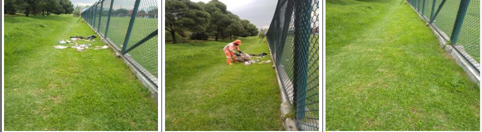
Instalación de baranda
