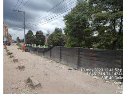
Se observa arreglo de cerramiento provisional e instalación de polisombra en sector 1 de la RDHTE.
