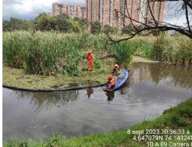
Se observa apertura de espejo de agua y control de especies invasoras en el sector 2 de la RDHTE.
