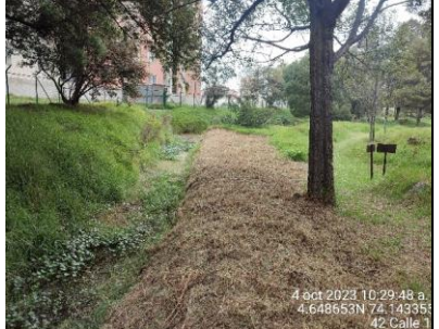
Se observa poda de pasto kikuyo en talud del sector 2 de la RDH Techo.
