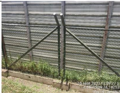
Se observa arreglo de cerramiento definitivo en el sector 2 de la RDHTE.
