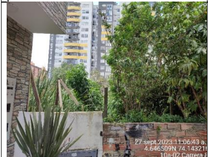
Se observa arreglo de cerramiento provisional en el sector 1.1. de la RDHTE.
