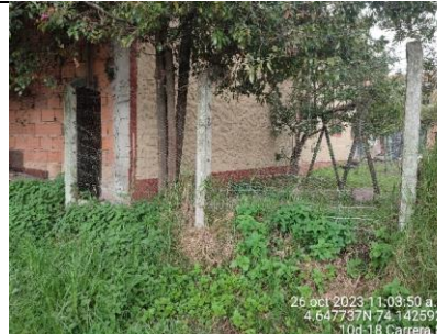
Se observa arreglo al cerramiento provisional en el sector 2 de la RDH Techo.
