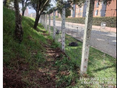
Se observa arreglo de cerramiento provisional en el sector 1 de la RDHTE
