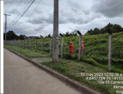
Se observa instalación de malla tipo gallinero en el sector 1 de la RDHTE.
