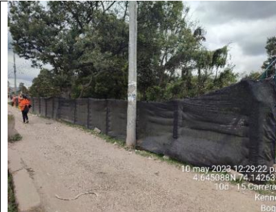
Se observa recolección de RSO en faja paralela del colector Villa Alsacia en el sector 1 de la RDHTE
