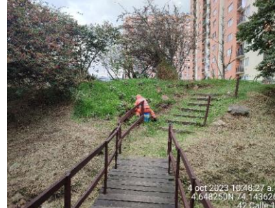
Se observa cambio de cobertura en el sector 2 de la RDH Techo.
