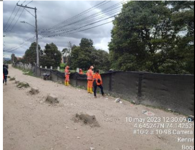
Se observa arreglo de cerramiento provisional en sector 1 de la RDHTE.
