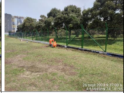
Se observa arreglo de cerramiento definitivo en el sector 1 de la RDHTE.
