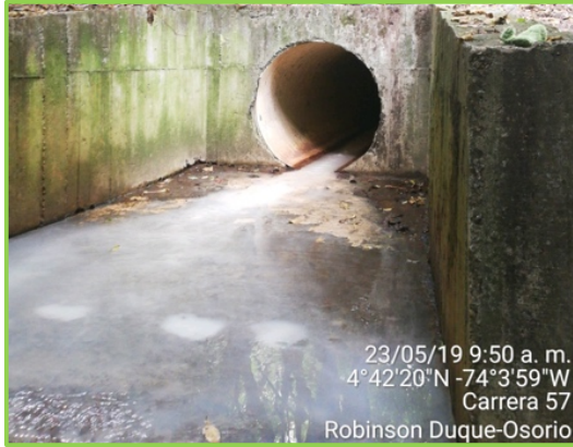
Foto 1. Contaminación hídrica por vertimiento de aguas contaminadas y/o conexiones erradas
