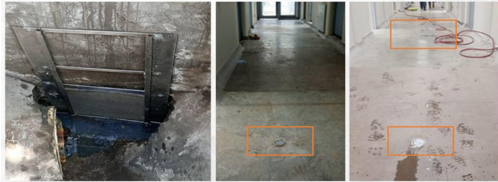
Instalación de Compuerta - Cambio de rejillas
