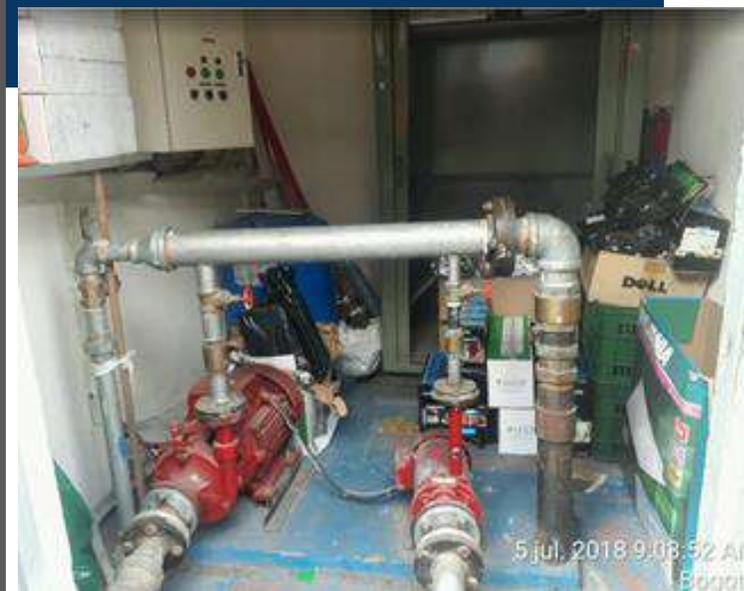
*. Inadecuado almacenamiento de residuos peligrosos, Cuarto de almacenamiento ubicado en el cuarto de bombas.*
