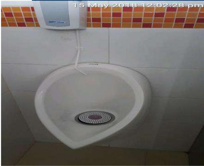
*Sistema hidrosanitario que no requiere agua para su funcionamiento. Edificio Nuevo, Personería de Bogotá.*
