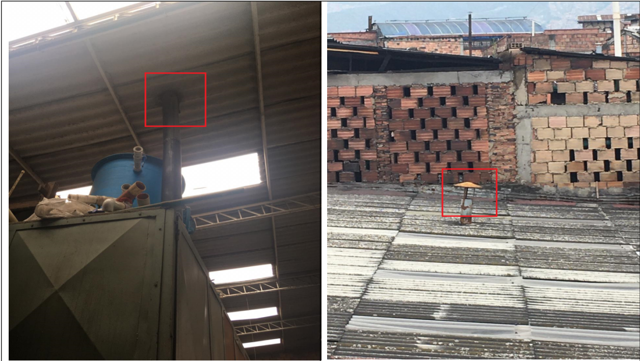
Fotografías No 9 y 10. Ducto de descarga.
