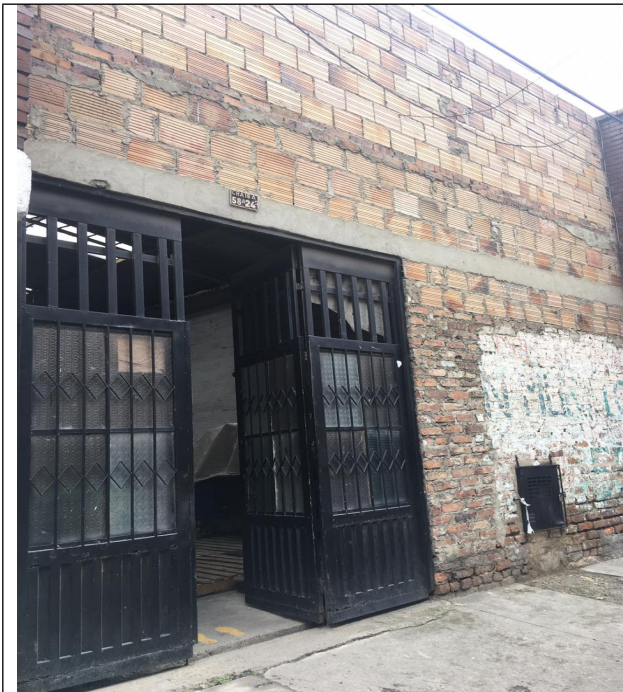
Fotografía No 1. Fachada del Predio.
