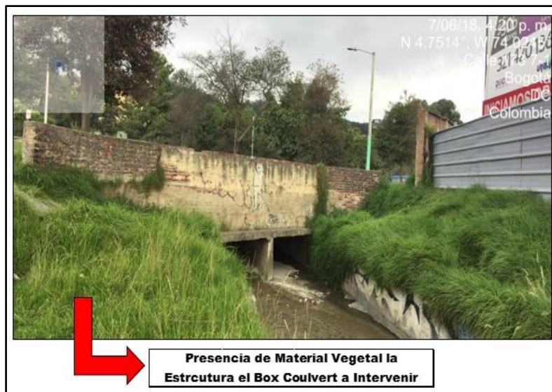
Ilustración 63: Box Coulvert a intervenir en el canal la Cita
