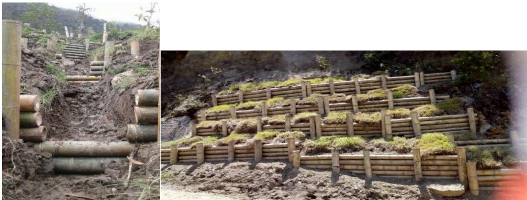
Ilustración 6: Instalación de trincho vivo escalonado y terraza en la vereda Las Palmas, localidad de Sumapaz
