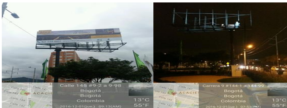
Ilustración 11: Desmonte de vallas
