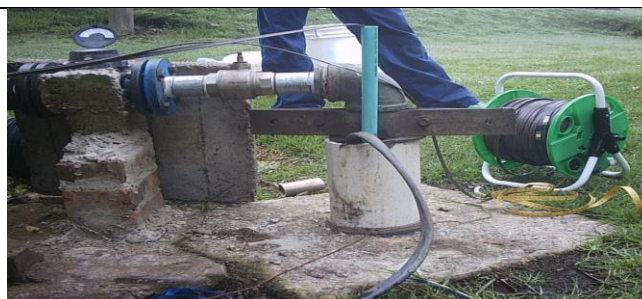
INSTALACION DE TUBERIAS DE TOMA DE NIVELES
