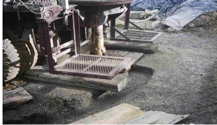
PERFORACION DE POZOS
